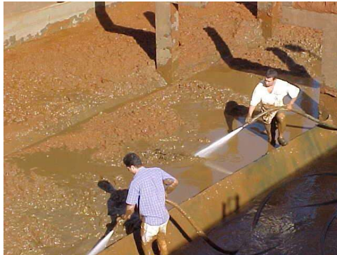
Figura 3.7 - Funcionários utilizando mangueiras d'água a alta pressão para facilitar a remoção do lodo do fundo do decantador de uma ETA
