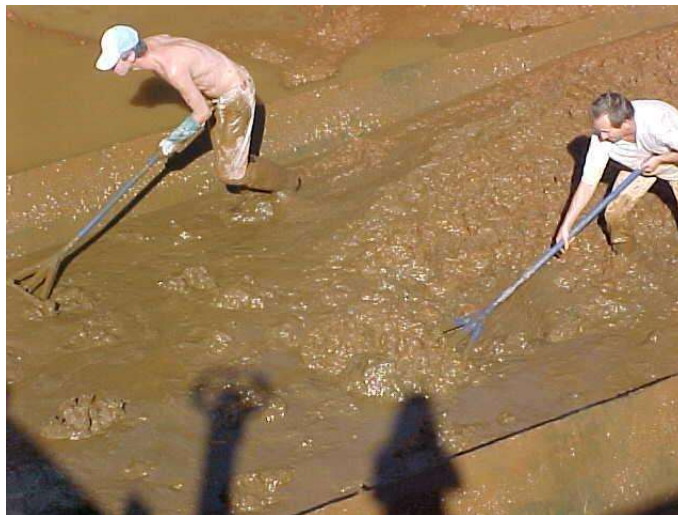
Figura 3.8 - Funcionários se esforçam para remover a camada espessa de lodo com o auxílio de rodos de madeira
