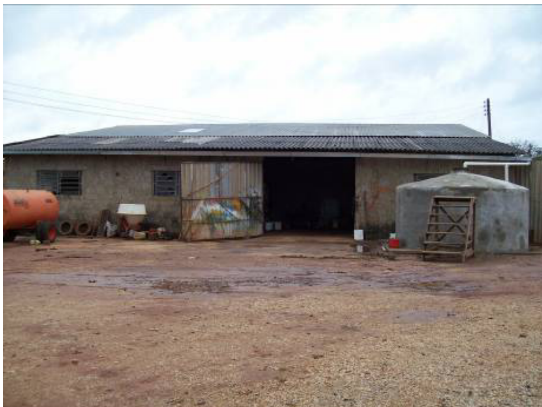
Figura 18 - Sistema de captação de água de chuva construído no assentamento
