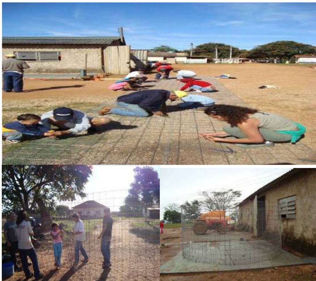
Figura 12 - Continuação das etapas do passo 2 para construção do sistema de captação de água de chuva
