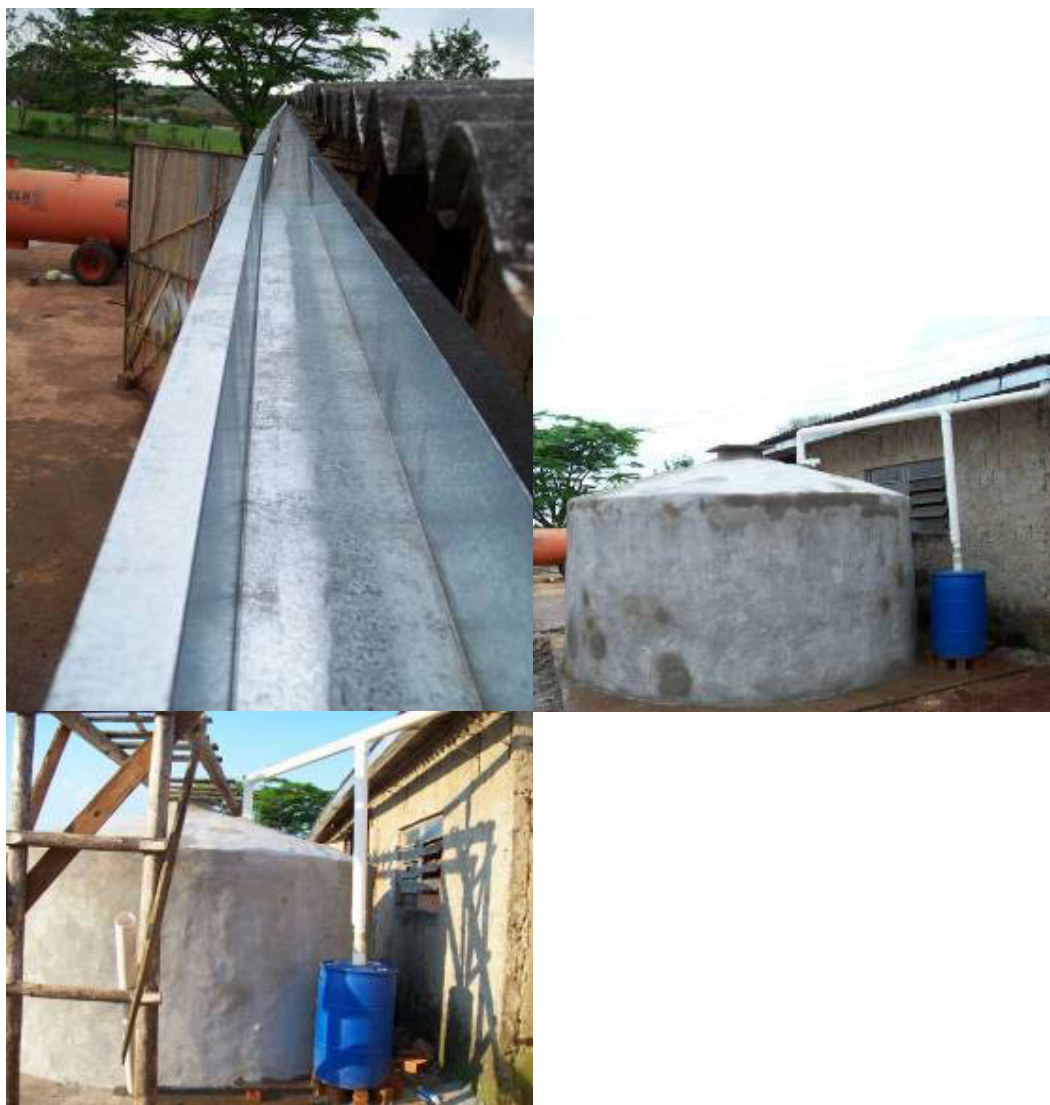
Figura 17 - Etapas do passo 5 para construção do sistema de captação de água de chuva.
