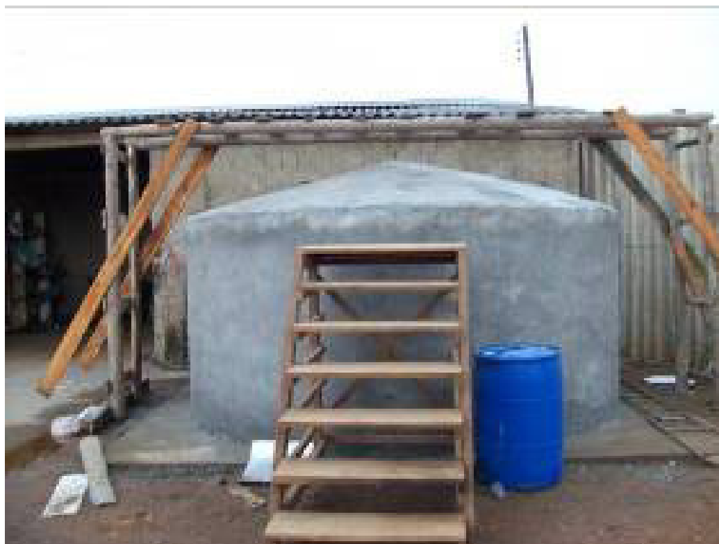
Figura 15 - Cisterna após as aplicações de argamassa
