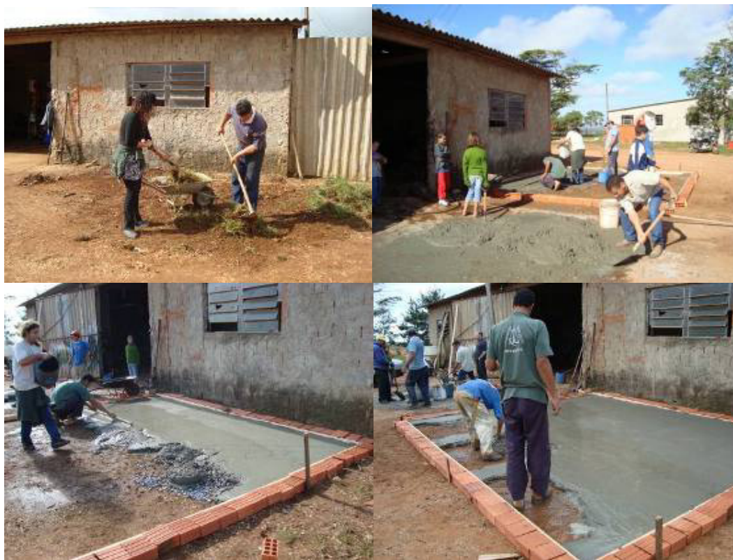
Figura 10 - Etapas do passo 1 da construção do sistema de captação de água de chuva
