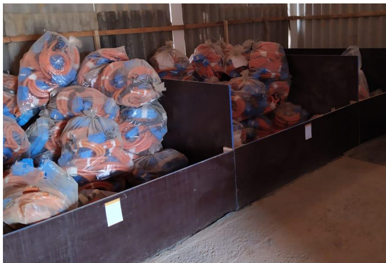
Figura 16 - Imagem de obra mostrando boas práticas no armazenamento dos kits.
