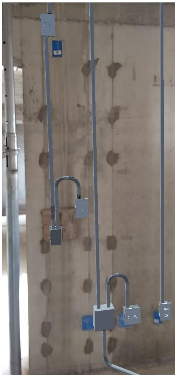
Figura 17 - Imagem de aplicativo de Realidade Aumentada mostrando modelo digital locado sobre o caso real em obra.
