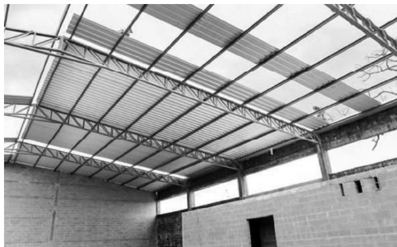
Figura 50 – Vista da cobertura do novo barracão da Cooperviva
