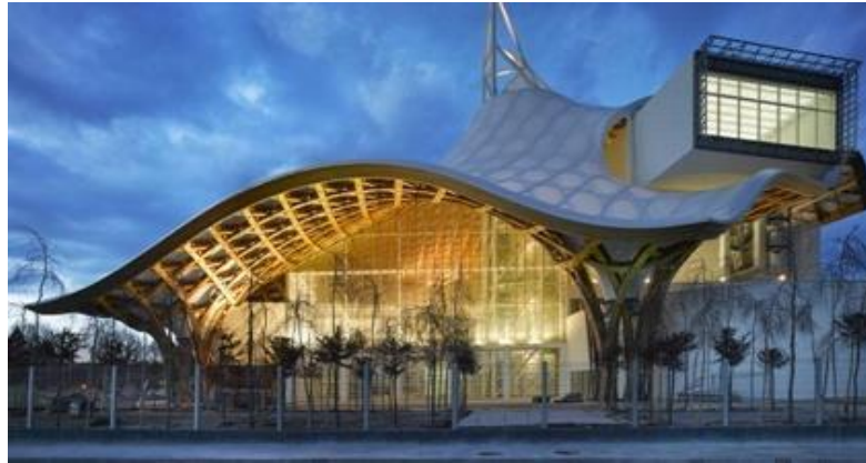
Figura 3 - Telhado de madeira laminada colada do museu de arte moderna e contemporânea Centro Pompidou de Metz, na França.
