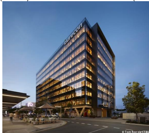
Figura 6 - O Edifício 25 King Street é o maior edifício comercial em madeira da Austrália, com 10 pavimentos e 45 metros de altura. A estrutura é feita de um misto de madeira laminada colada (Glulam) e madeira laminada cruzada (CLT).
