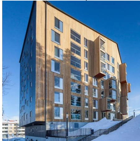
Figura 5 - O Prédio Puukuokka, na Finlândia, é um dos primeiros do mundo feito com madeira com lâmina pré-fabricada.
