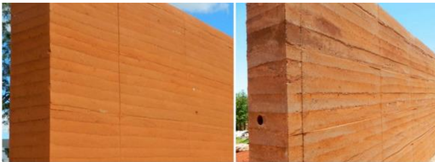
Figura 6 - Parede 1 (a) e parede 2 (b), com diferentes métodos de homogeneização. Fonte: Adaptado por Veraldo (2015) de Heise et al. (2012)
