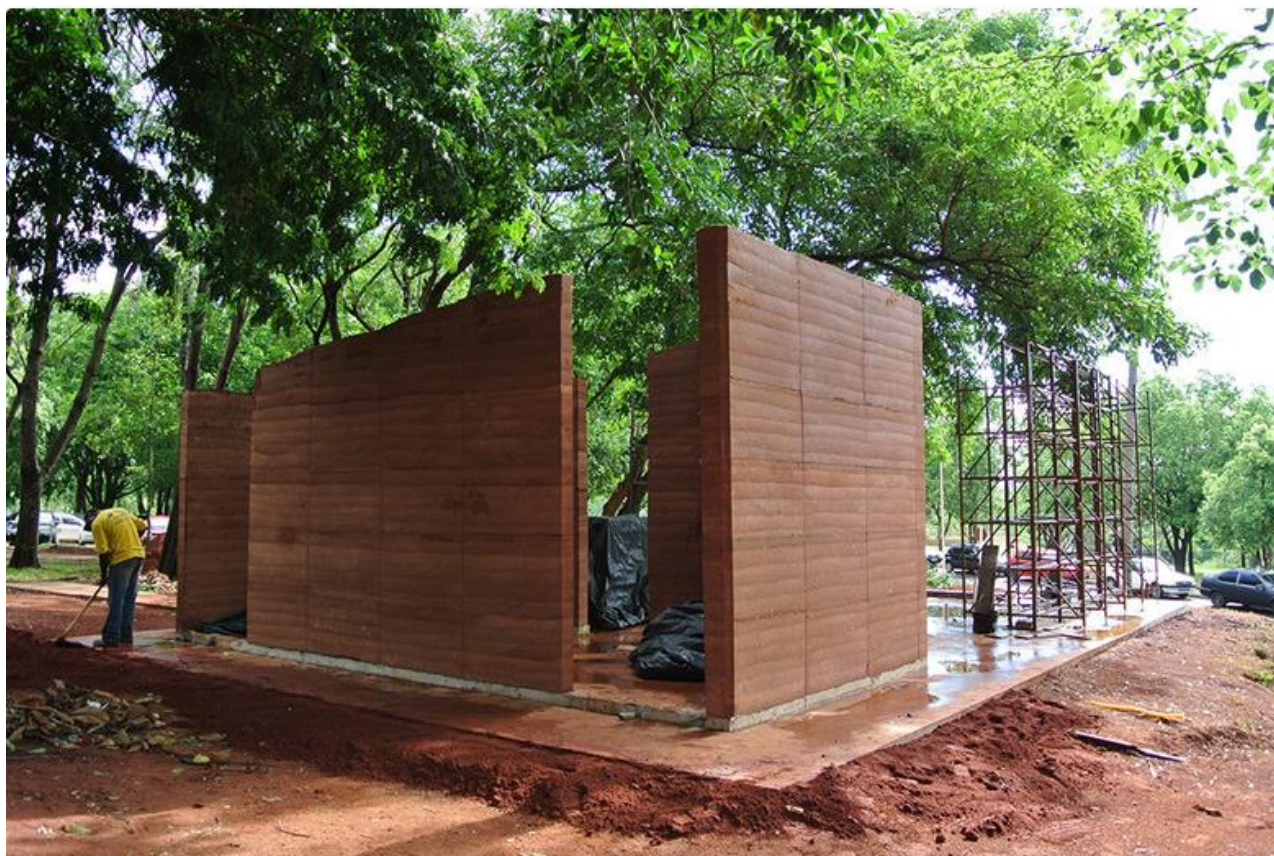
Figura 1 - Construção em taipa de pilão na UFMS. Fonte: UFMS (2014)
