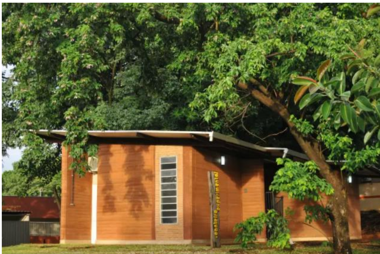
Figura 2 - Construção em taipa de pilão finalizada na UFMS. Fonte: Alcides Neto (2016)
