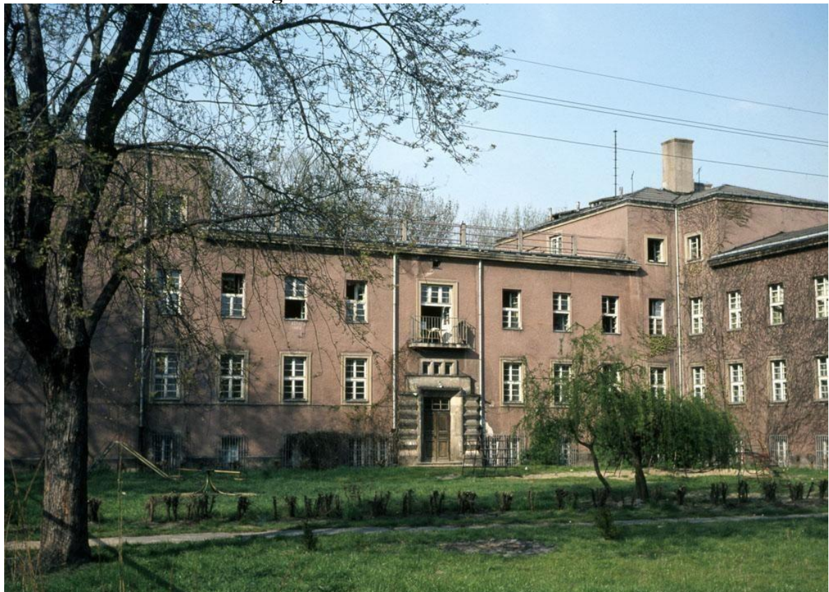
FIGURA 12 -Fotografia da fachada interna do orfanato Nasz Dom
