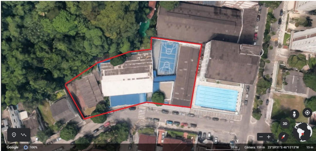
Figura 3 - Vista aérea da escola em estudo. Fonte: Google Earth, (2021).
