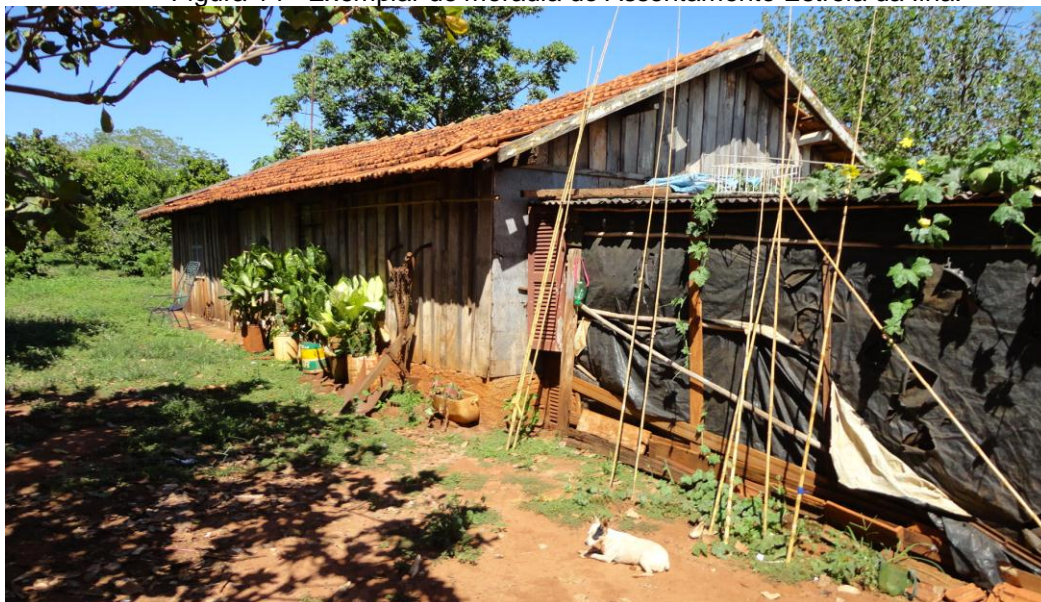
Figura 14 - Exemplo de moradia do Assentamento Estrela da Ilha.
