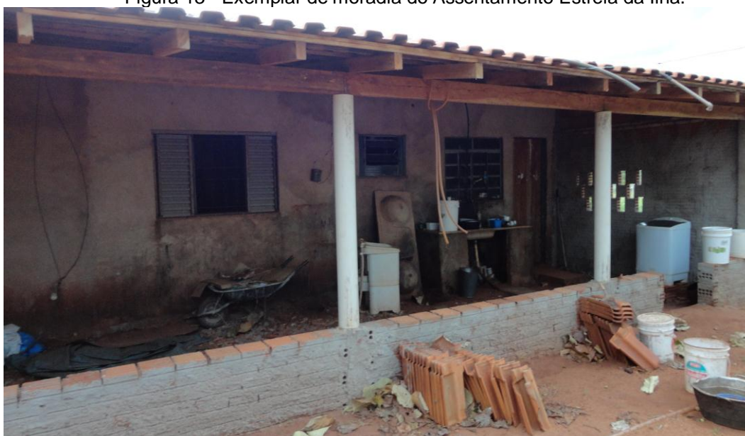
Figura 13 - Exemplar de moradia do Assentamento Estrela da Ilha.
