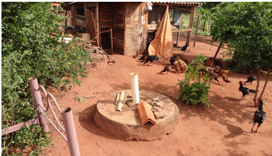
Figura 27 – Exemplar de uma fossa em lote do Assentamento “Estrela da Ilha”
