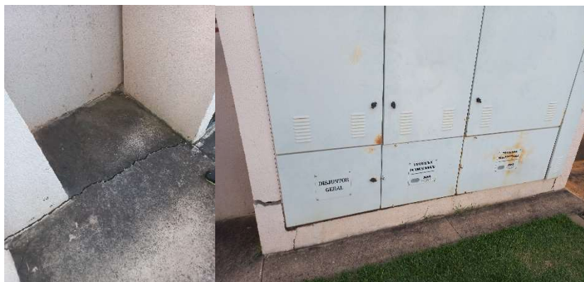
Figura 23: Rachaduras
