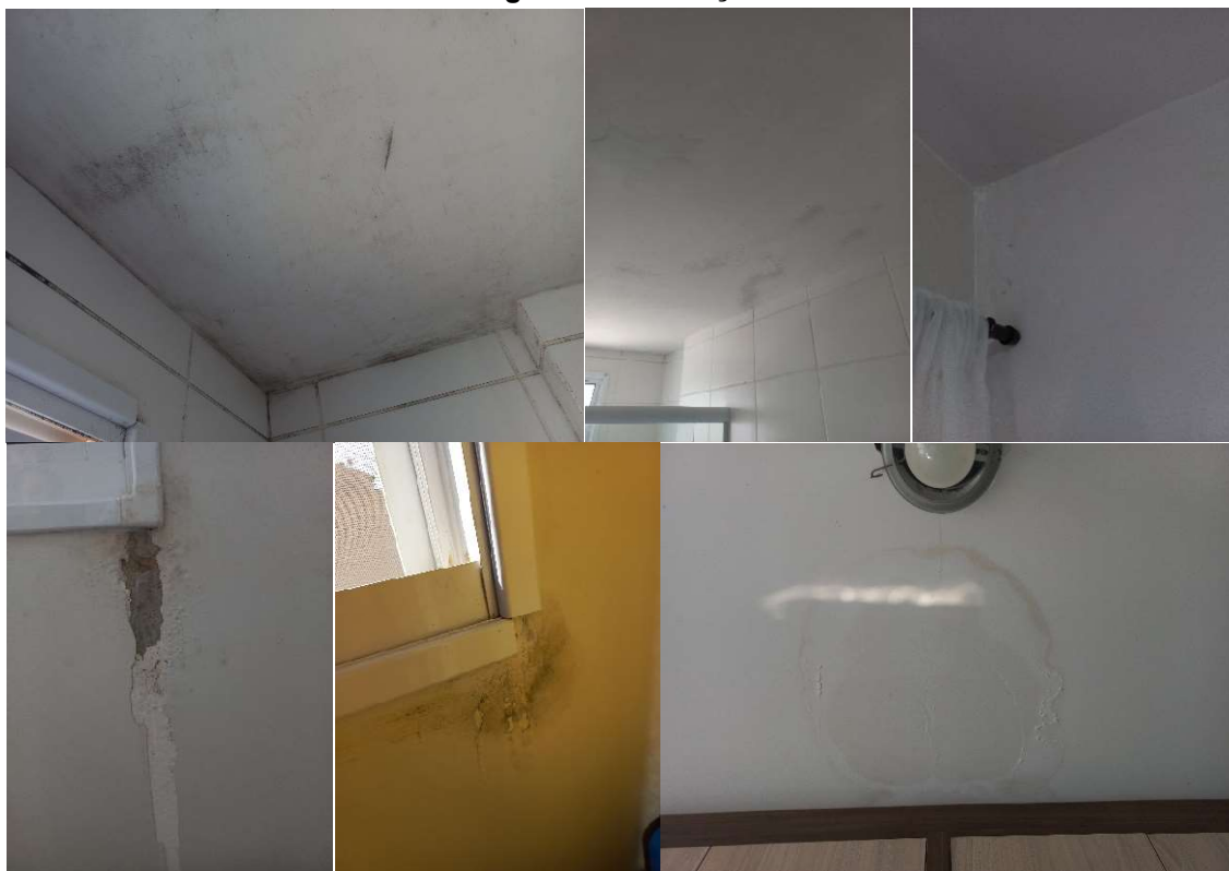
Figura 27: Infiltração
