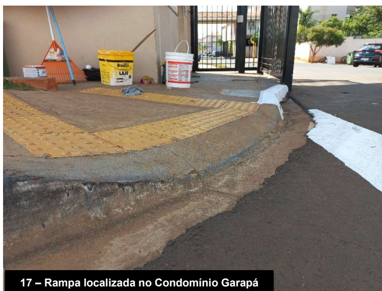
Figura 12: Rampa para Pessoa com Mobilidade Reduzida (PMR) - condomínios
