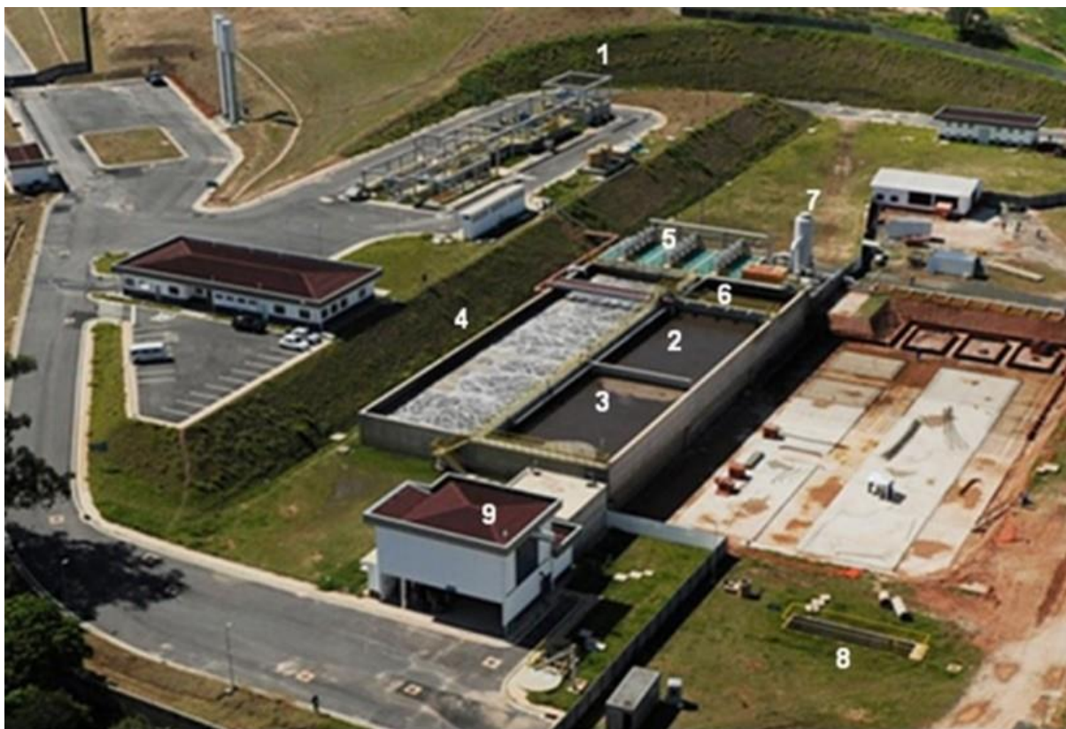
Figura 4.1 – Imagem aérea da Estação Produtora de Água de Reuso Capivari II (ANDRADE et al., 2014).
