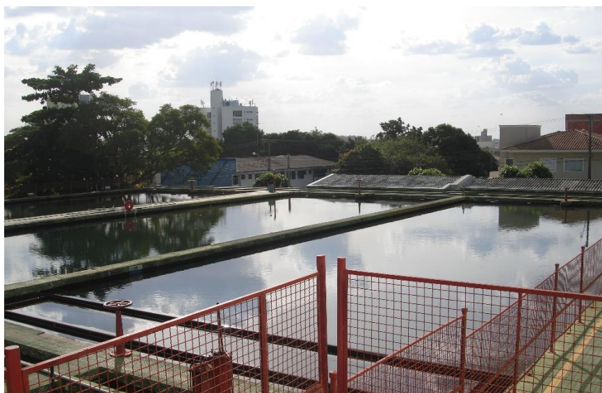
Figura 19 - Decantadores onde o LETA é depositado na ETA de São Carlos
