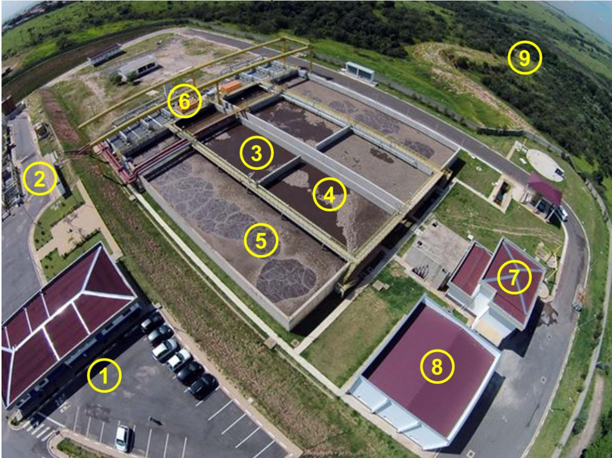
FIGURA 5.1. Vista aérea da EPAR - Capivari II.
