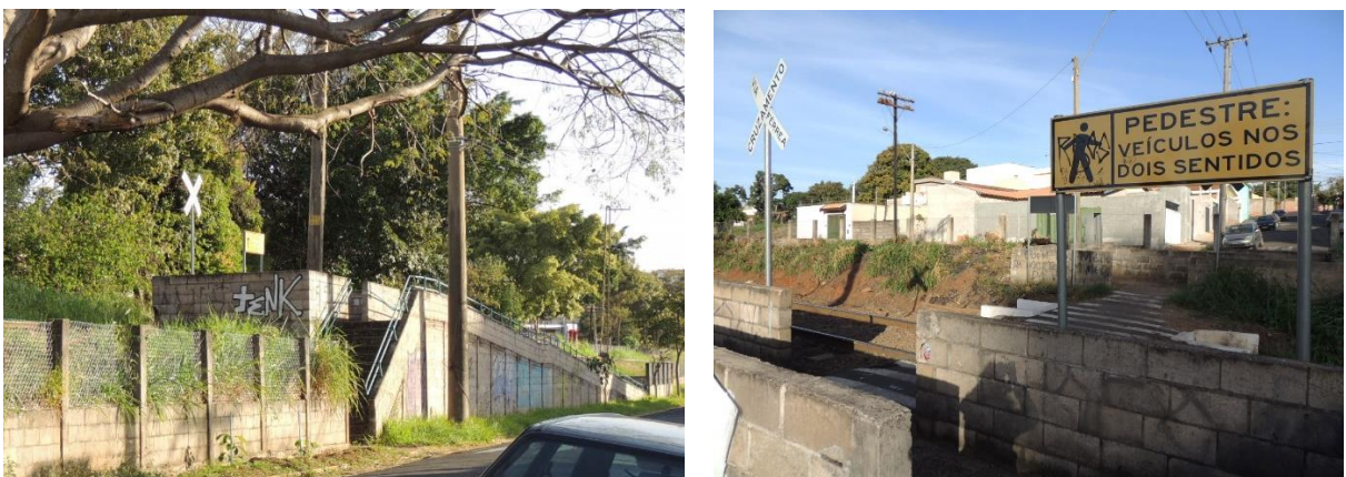
Figura 3 — Sinalização em passagem de pedestre regular
