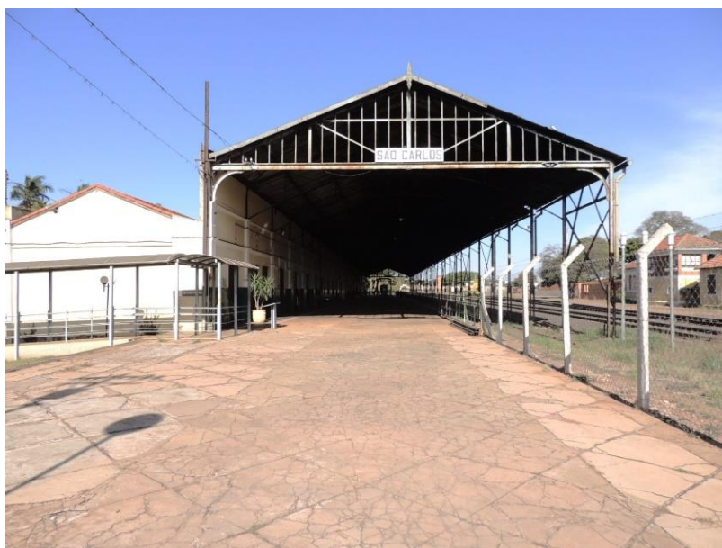
Figura 35 — Estação ferroviária de São Carlos (2022)
