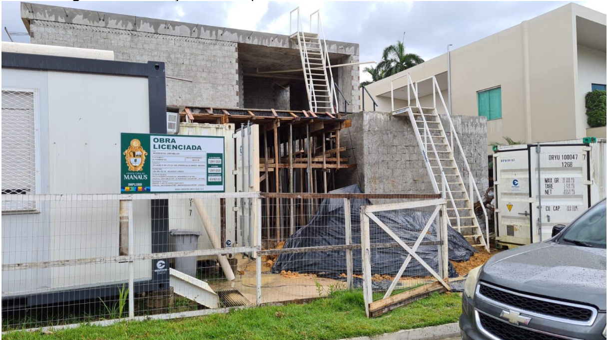
Figura 30. Construção utilizada para o levantamento de dados no estudo de caso.
