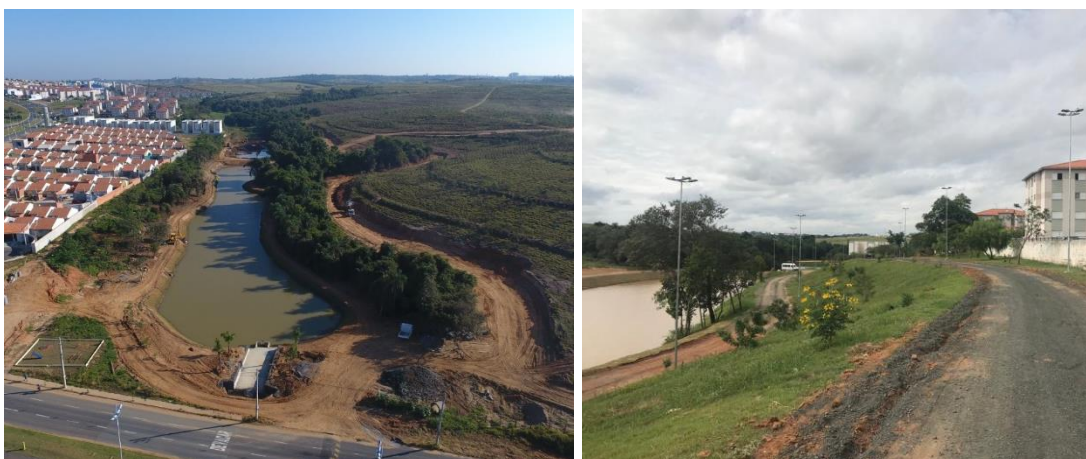
Figura 61: Obras no Parque do Buru. 2022.
