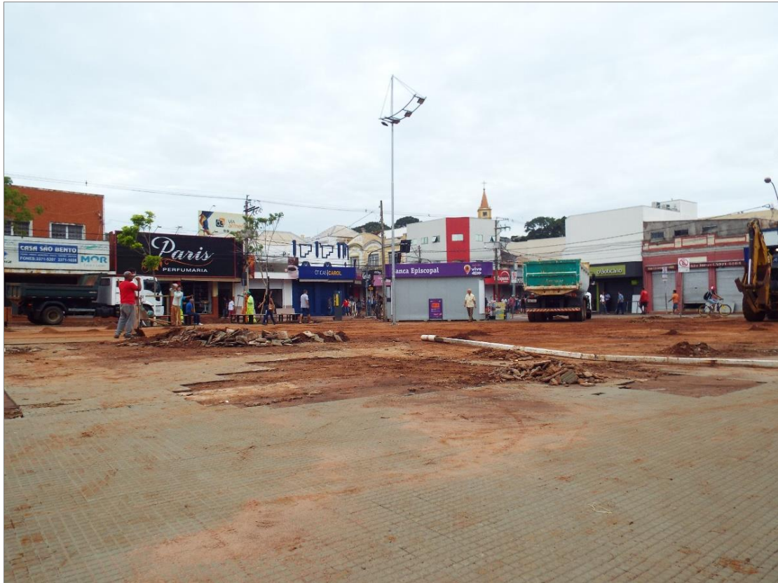
Figura 17: Praça do Mercado Municipal. Fonte: Trabalho de campo 20 de janeiro de 2020.
