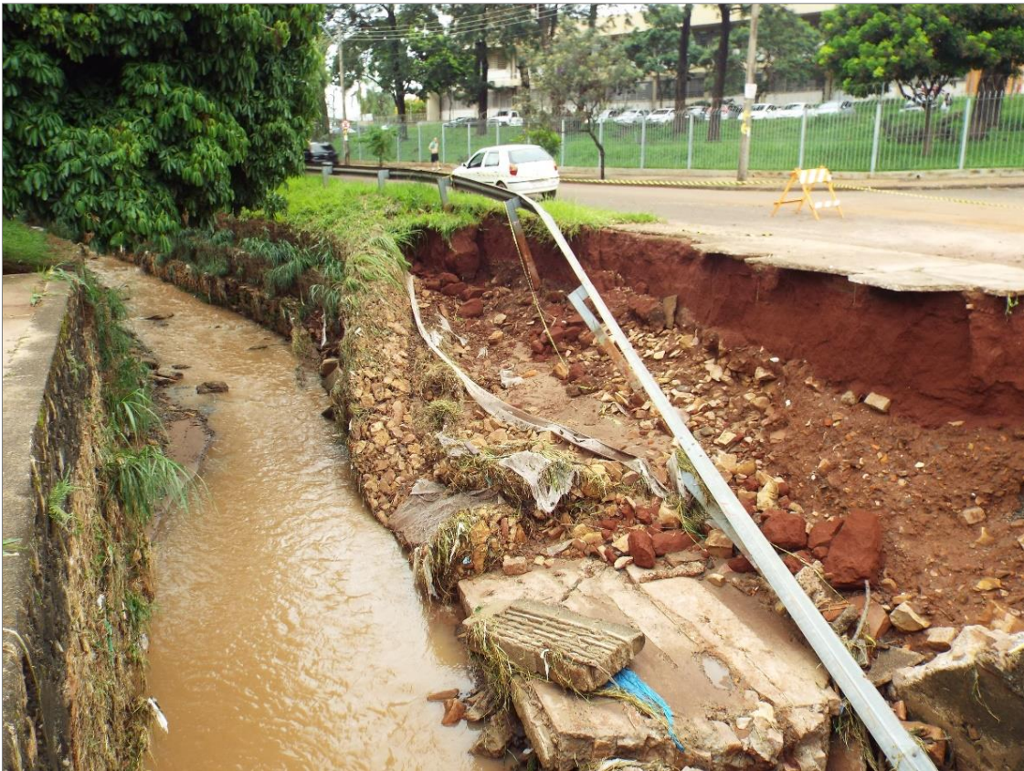
Figura 16: Trecho da Av. Comendador Alfredo Maffei, colapsado. Fonte: Trabalho de campo 20 de janeiro de 2020.
