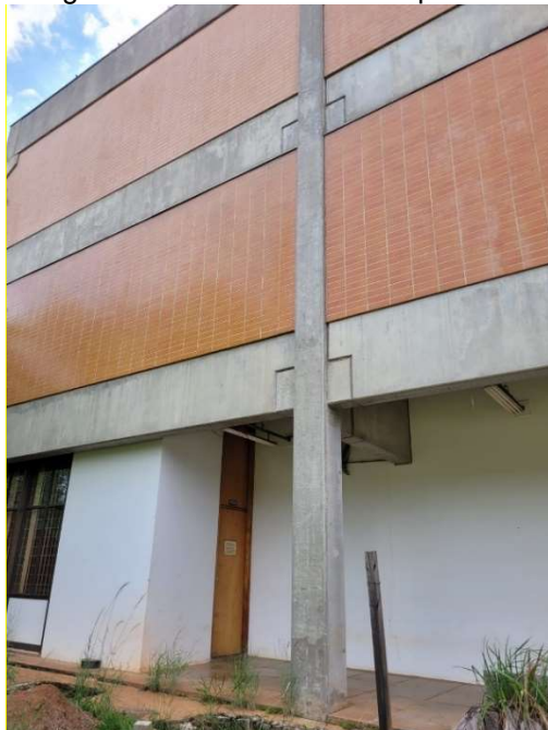
Figura 11 – Fechamento das paredes
