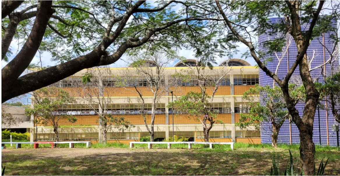
Figura 13 – Fachada norte BCo
