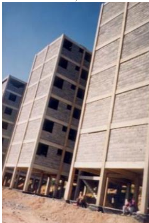
Figura 5 - Foto Guaianazes B10, alvenaria de blocos de concreto
