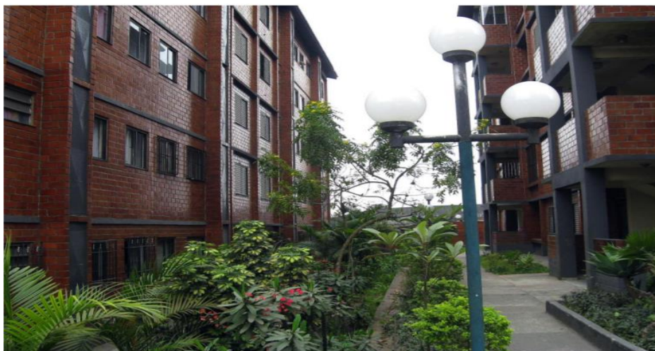
Figura 3 - Foto Guaianazes A5, alvenaria de blocos cerâmicos
