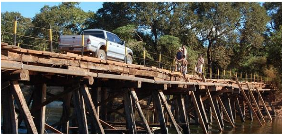
Figura 6: Ponte que dá acesso ao Campus Edgard Santos
