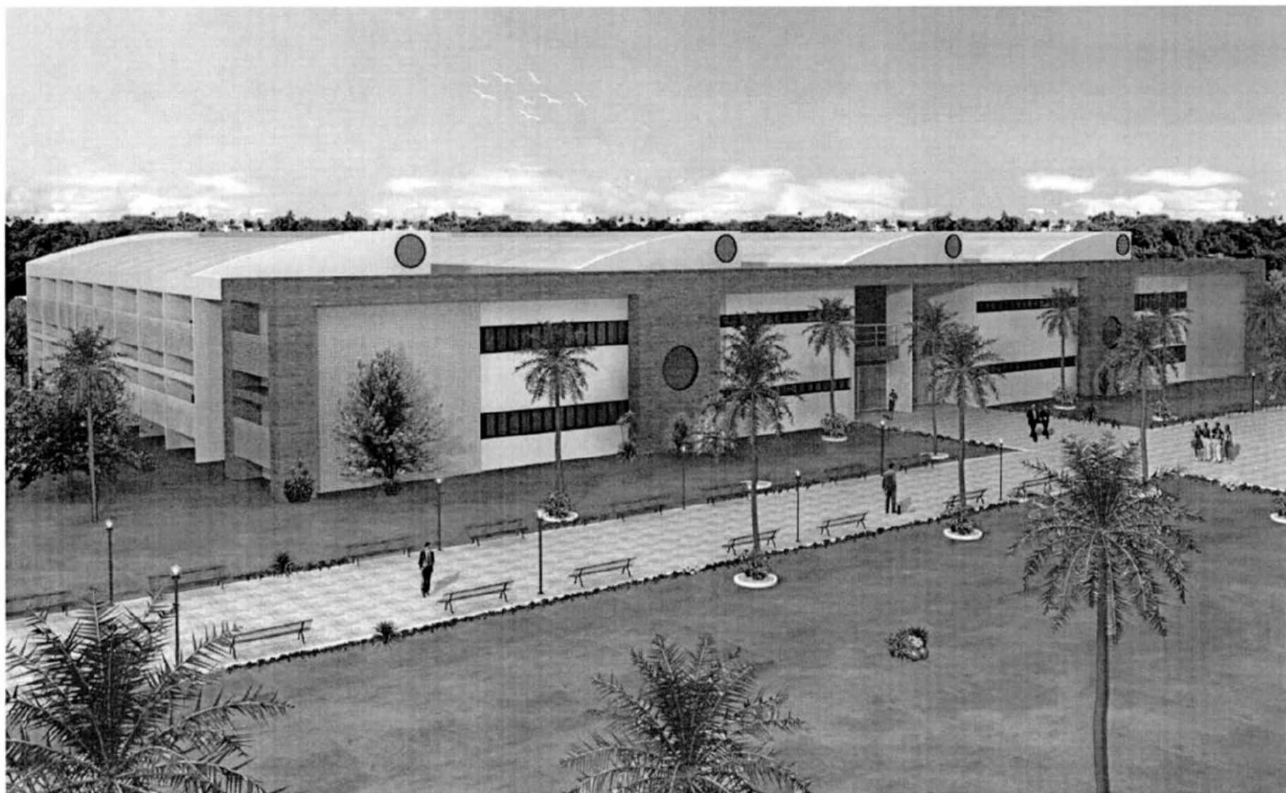
Pavilhão de Aulas: Obras em andamento.
