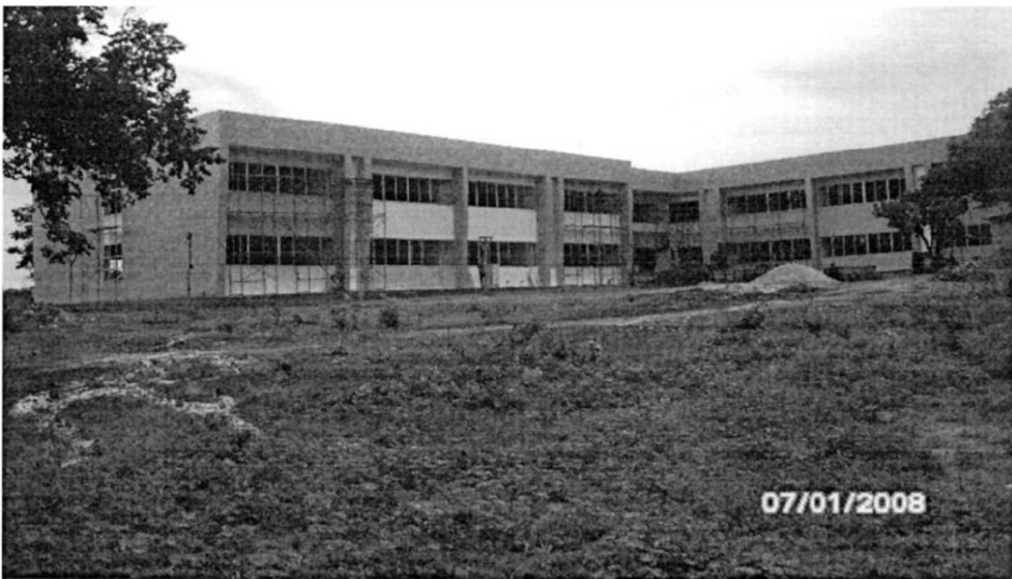
Prédio de Laboratórios: Entrega para maio de 2008
