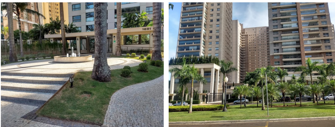
Figura 105 – Fachada de condomínios residenciais na Av. Prof. João Fiúsa
