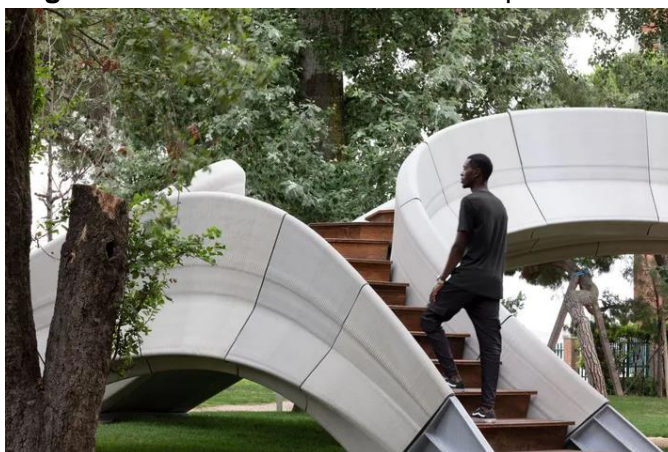
Figura 7: Ponte futurista feita com impressora 3D
