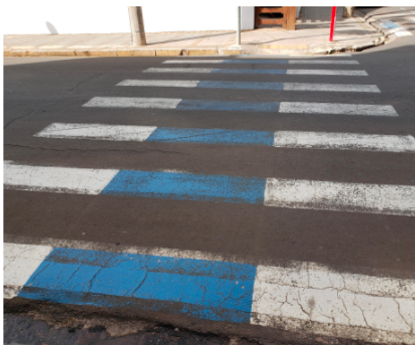
Figura 9: Faixa de pedestres modificada em São Carlos
