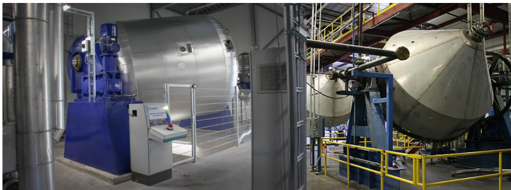
Figura 14. Exemplos de reatores batelada SSP
