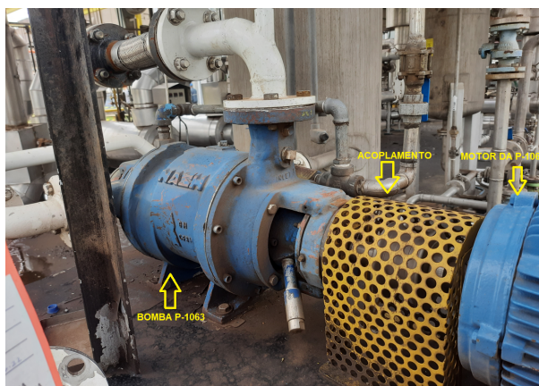
Figura 13 – Conjunto Bomba de Vácuo 1063
