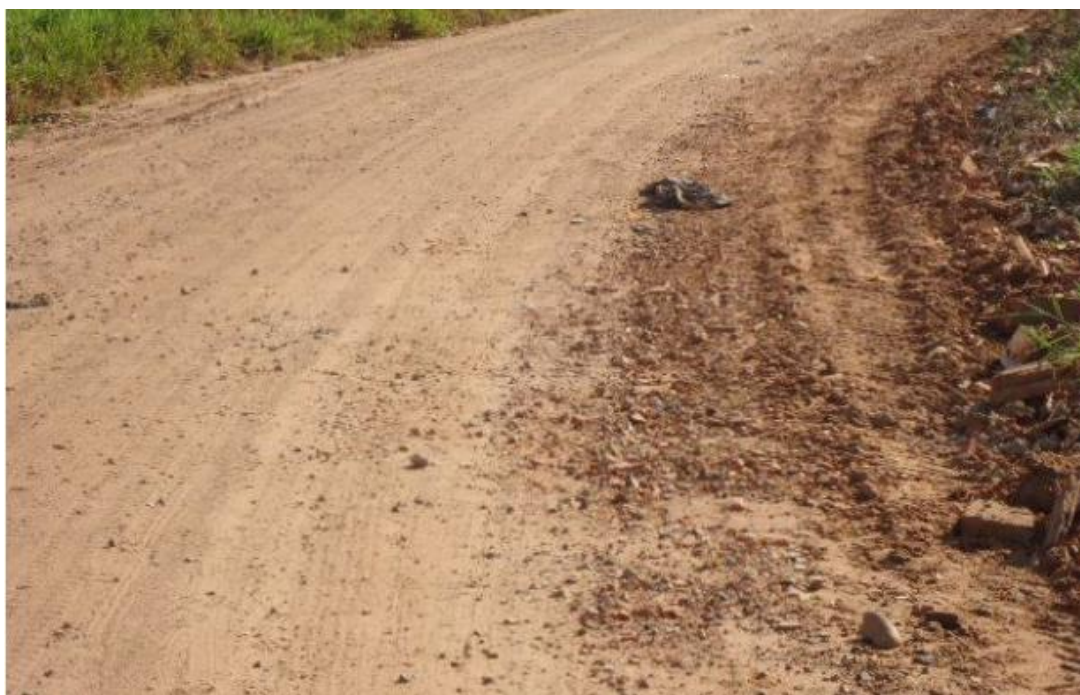
Figura 64 - RCC de Icém utilizado em estradas rurais
