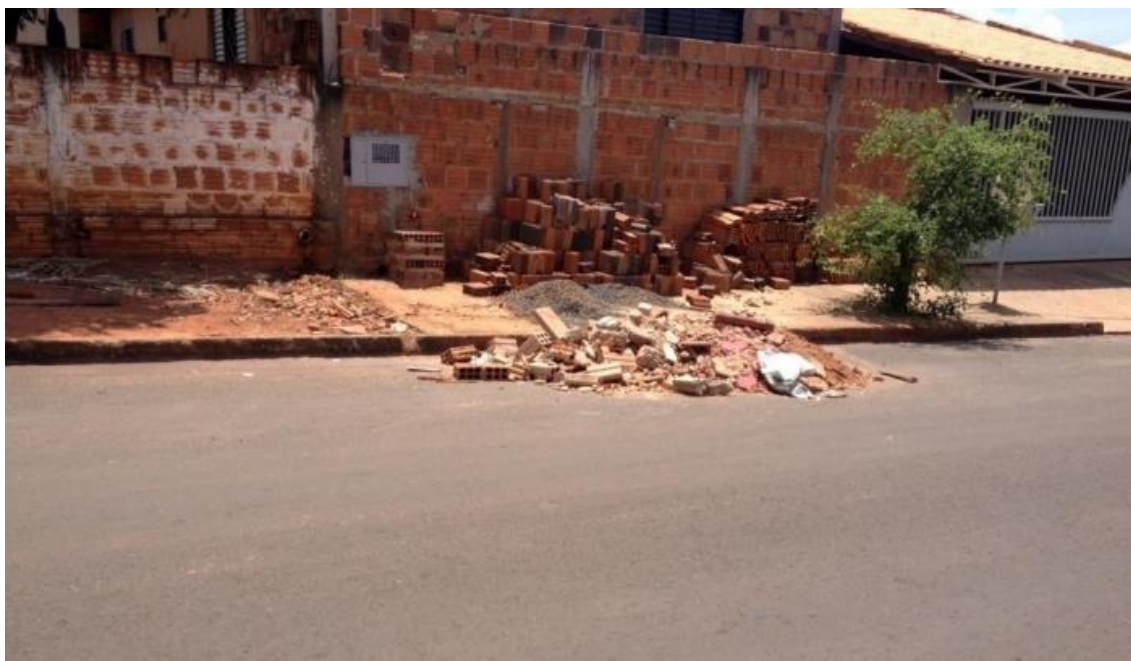
Figura 84 - RCC aguardando coleta da prefeitura de Terra Roxa
