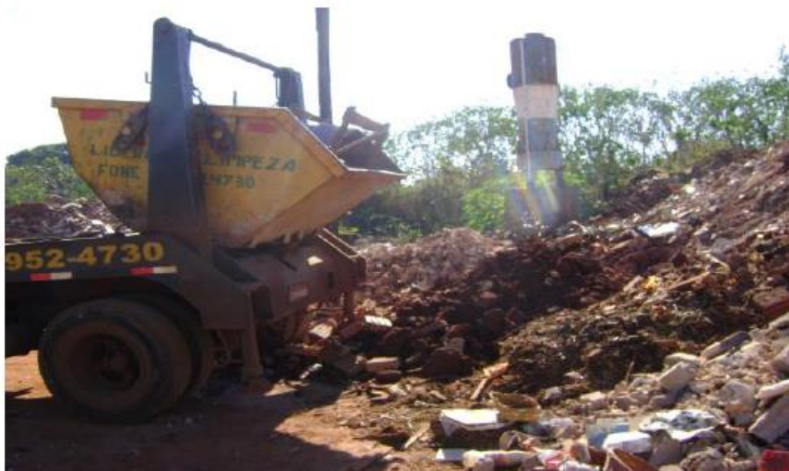
Figura 90 - Área de deposição de RCC em Viradouro
