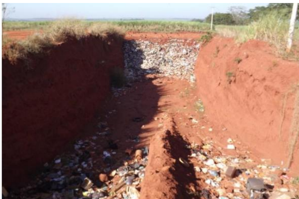
Figura 58 - Vala com resíduos no Aterro de Guaraci
