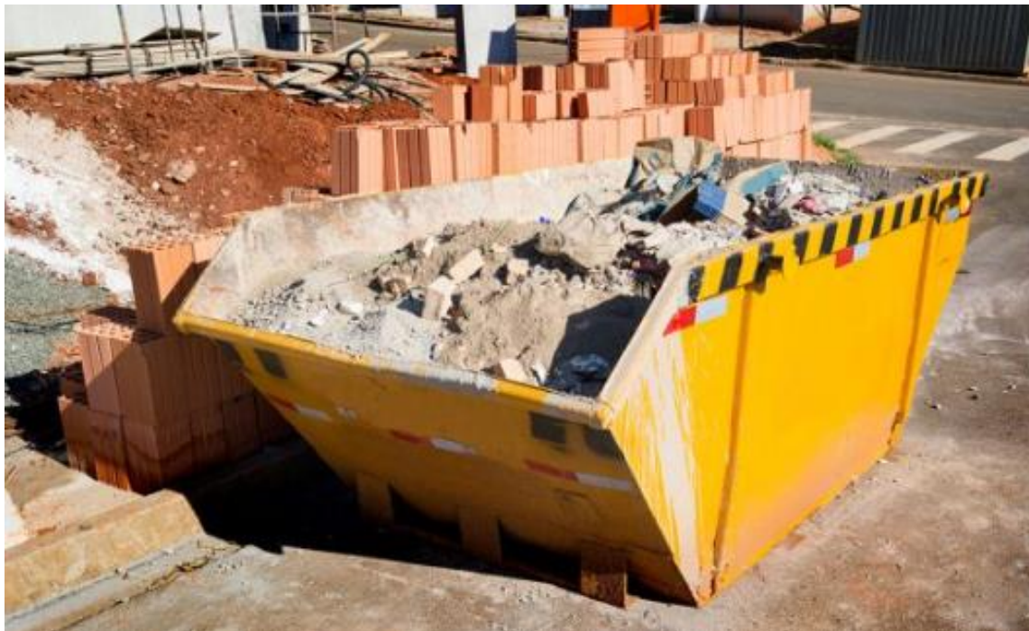
Figura 40 - Coleta de RCC pela empresa Bebedouro Caçambas
