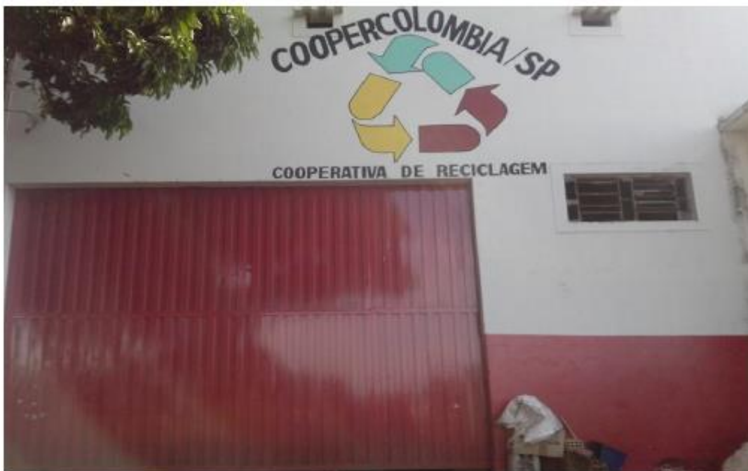
Figura 52 - Local de armazenamento de resíduos recicláveis de Colômbia
