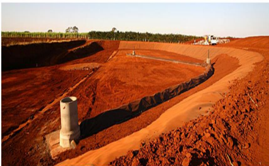
Figura 76 - Instalação da CGR Jardinópolis/SP
