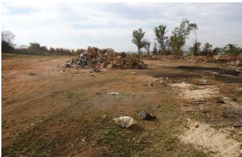
Figura 85 - Área de deposição temporária de RCC em Terra Roxa
