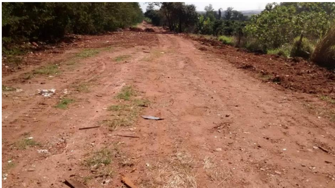
Figura 46 - RCC de Colina utilizado nas estradas rurais
