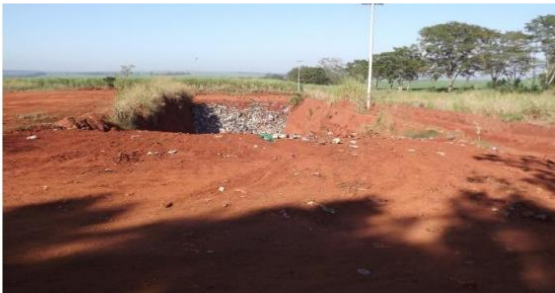
Figura 66 - Vista geral do aterro de Jaborandi
