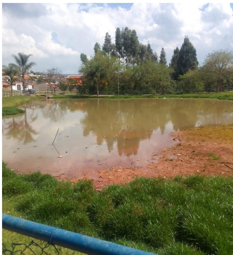
Figura 6 - Assoreamento acentuado causado por voçoroca – Lagoa do Colina, Cabreúva - SP
