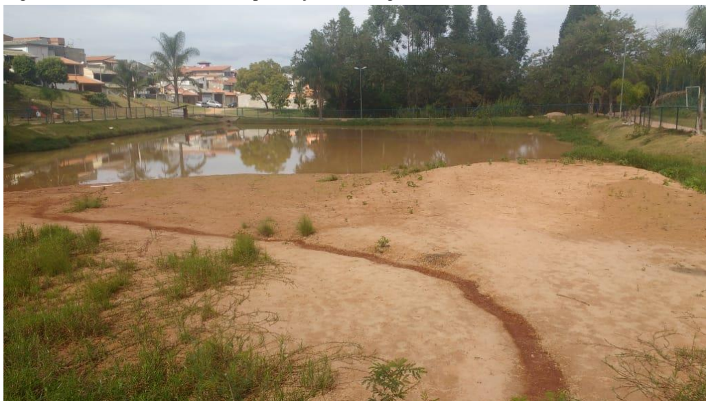
Figura 3 - Assoreamento causado por voçoroca – Lagoa do Colina, Cabreúva - SP
