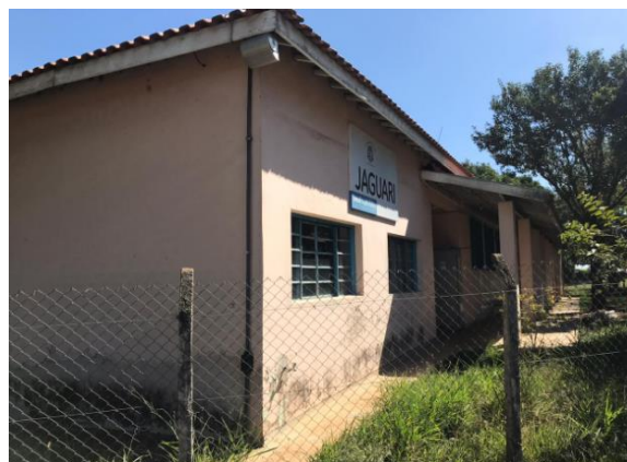
Foto 6. Visão lateral da EMEIEF Ângelo B.
