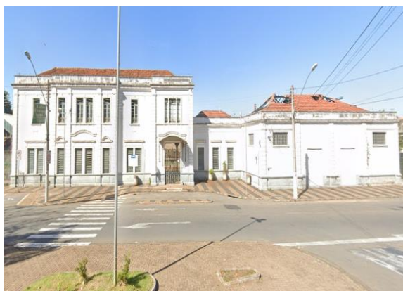
Foto 1. Visão frontal da Estação Ferroviária de Limeira
