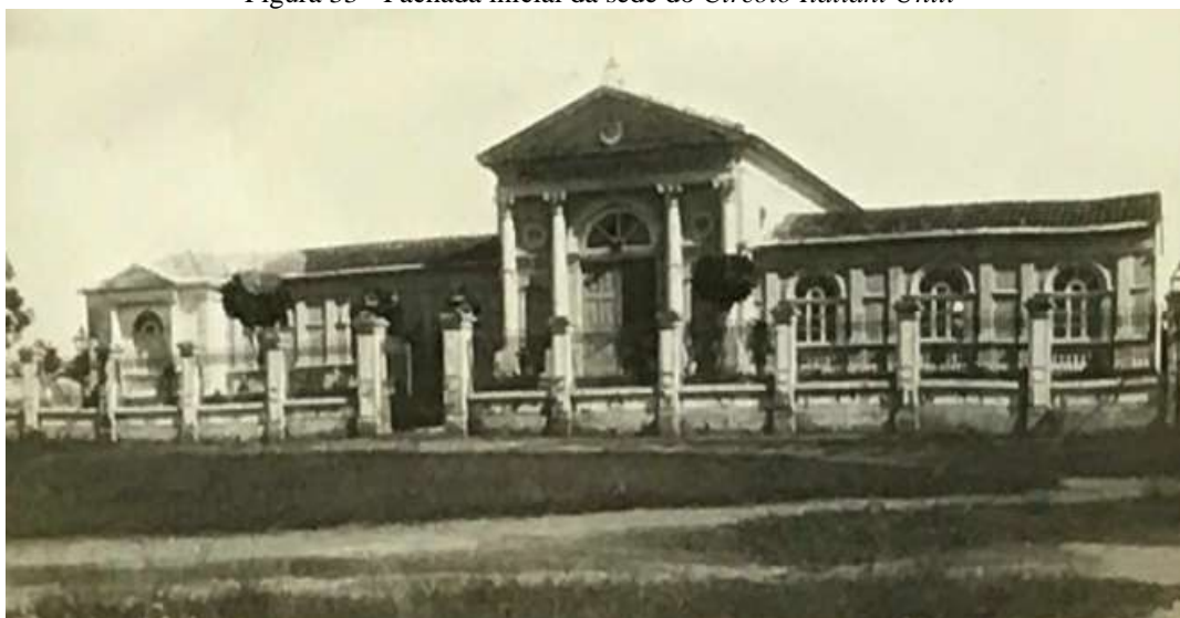
Figura 33 - Fachada inicial da sede do Circolo Italiani Uniti
