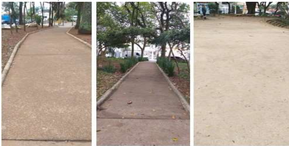
Figura 22. Caminhos de concreto em bom estado de conservação, Praça Visconde de Souza Fontes, Subprefeitura da Mooca, São Paulo.
