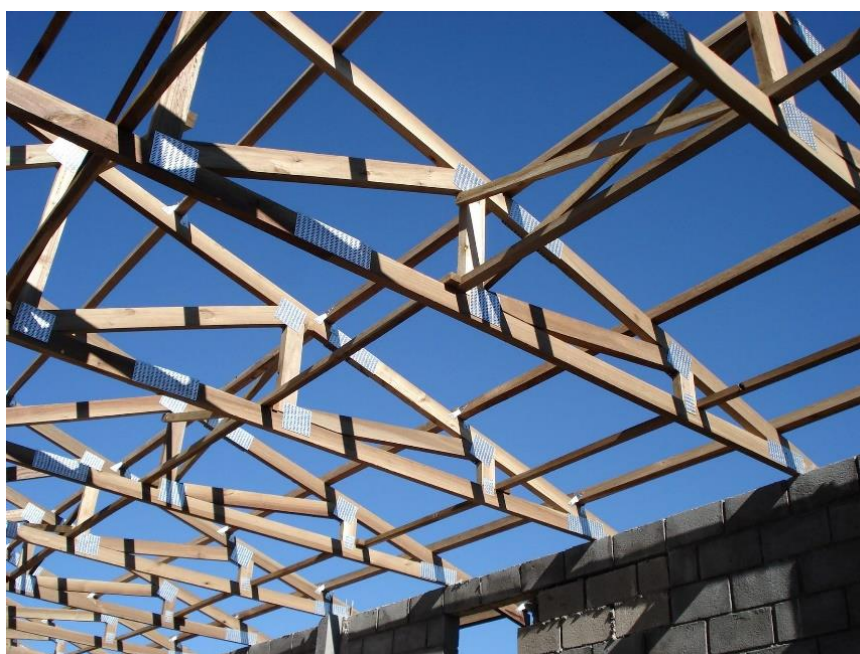
Figura 1.1 – Estruturas de cobertura em madeira.
