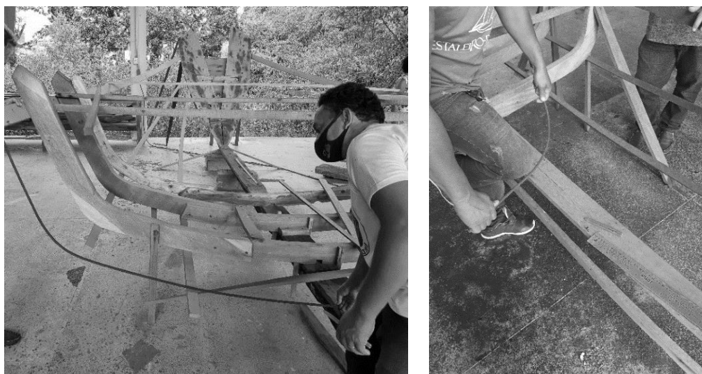
Figura 40 - Definição da curvatura da caverna de uma embarcação
