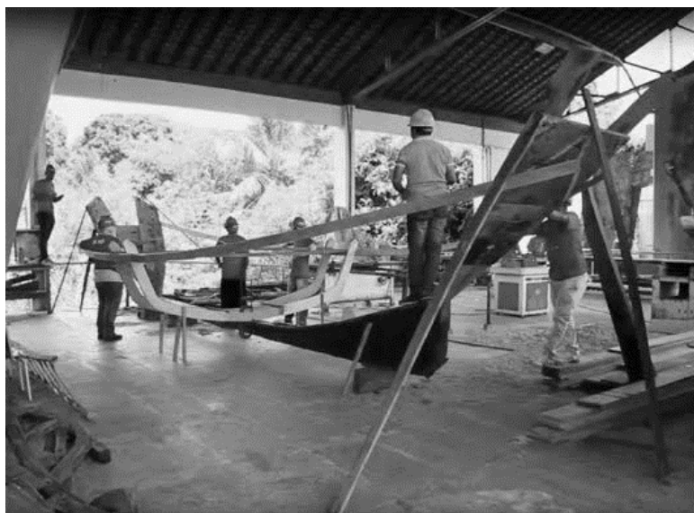
Figura 32 - Galpão da carpintaria naval do Estaleiro Escola
