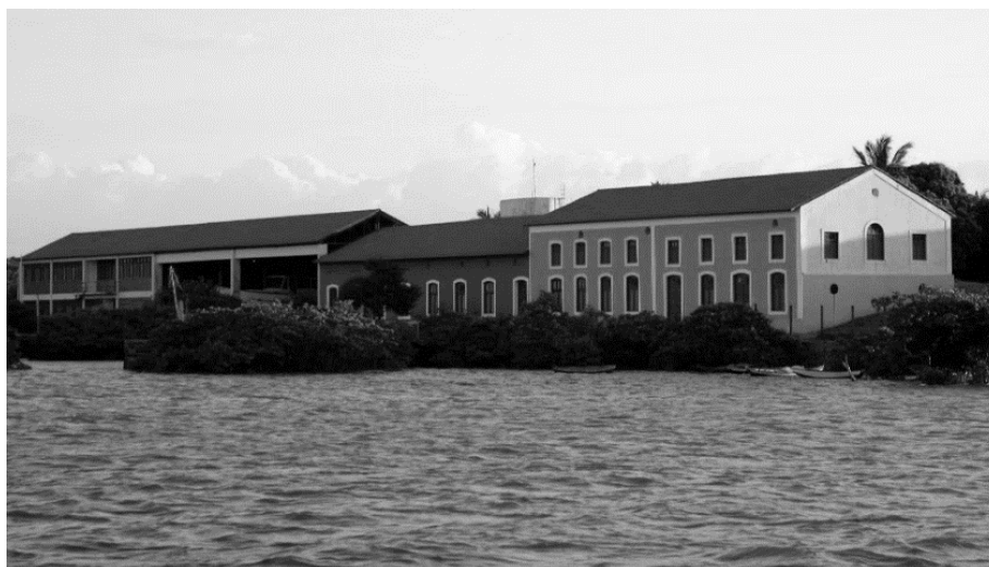
Figura 29 - Centro Vocacional Tecnológico Estaleiro Escola em São Luís - MA
