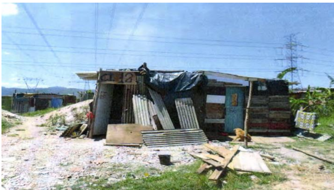
Figura 3 - Foto de moradias identificadas pela empresa transmissora de energia elétrica com numerações (2014)
