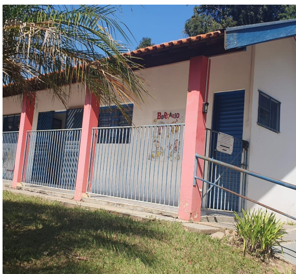
Foto 14-Entrada do Berçário, separada da creche
