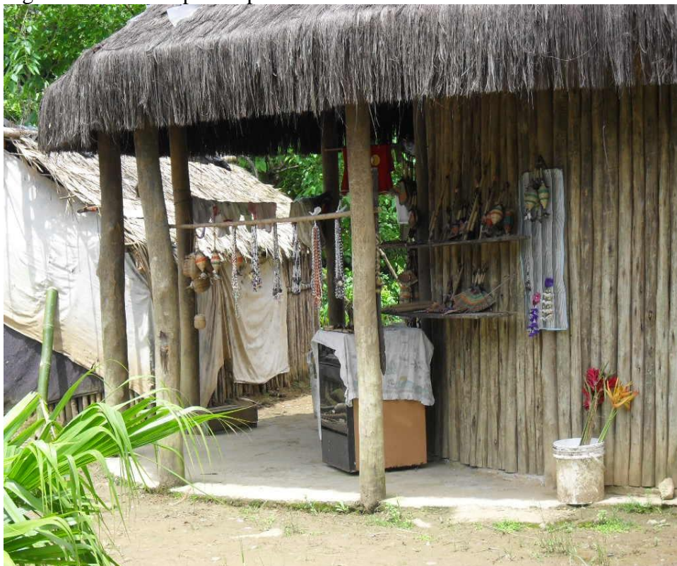
Figura 50 – Tembiapo nas paredes externas da casa
