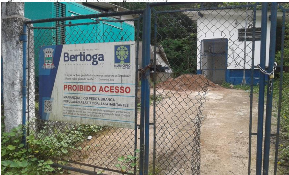
Figura 11 – Estação de captação de água da Sabesp
