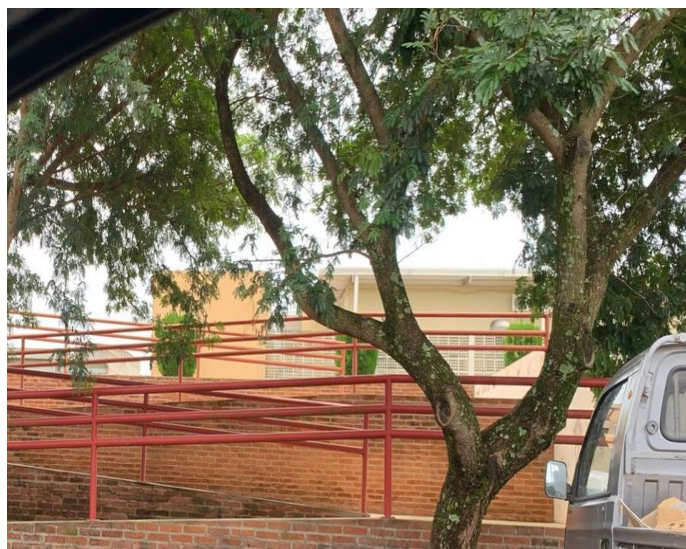
Figura 6: Rampa a ser percorrida.
