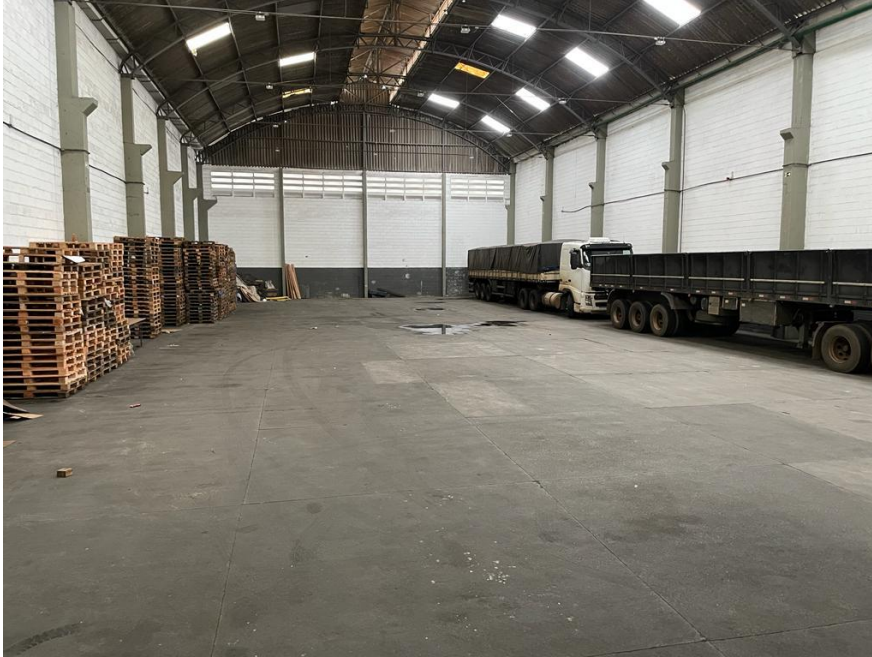
Figura 6.2 – Interior do galpão
