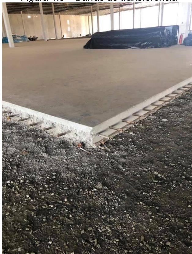
Figura 4.8 – Barras de transferência
