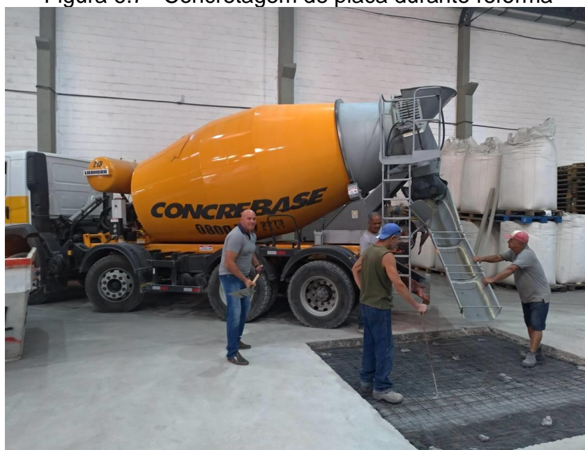
Figura 6.7– Concretagem de placa durante reforma
