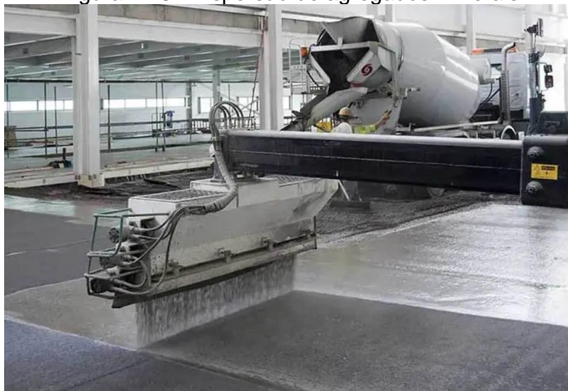
Figura 4.16 – Aspersão de agregados minerais
