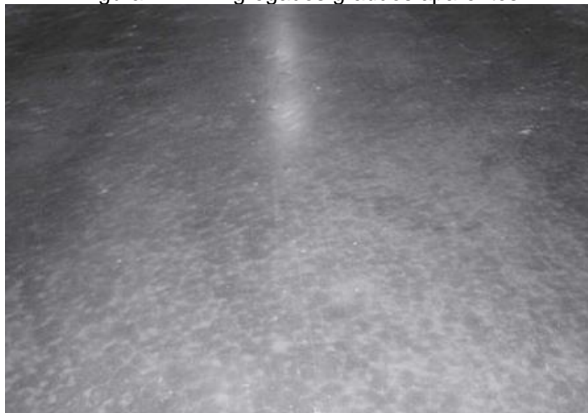
Figura 4.12 – Agregados graúdos aparentes
