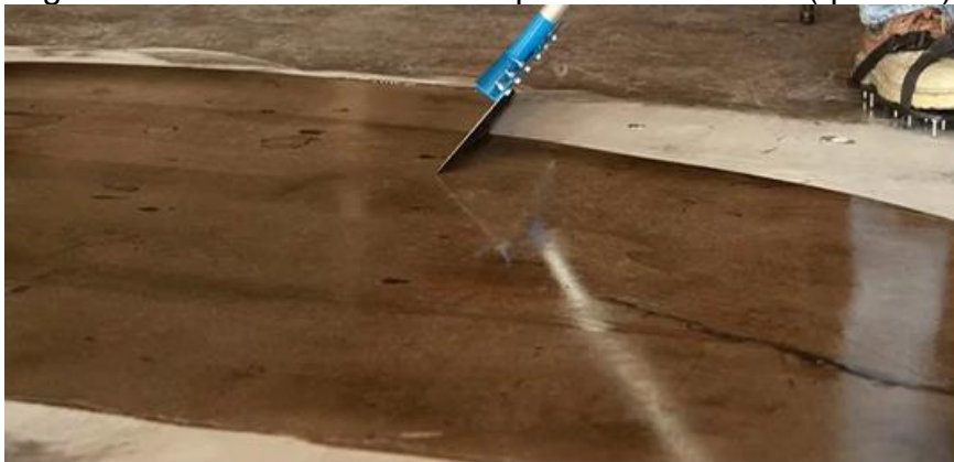
Figura 4.15 – Piso recebendo líquido endurecedor (químico)
