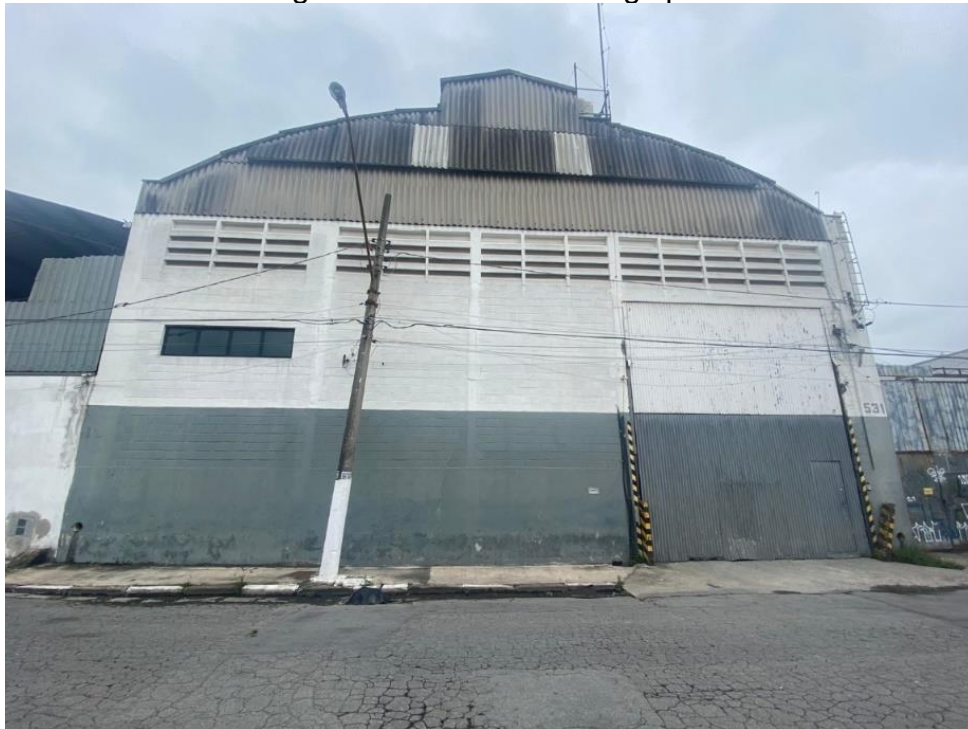
Figura 6.1 – Fachada do galpão
