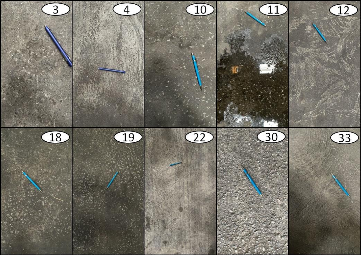
Figura 6.16– Regiões com desgaste por abrasão
