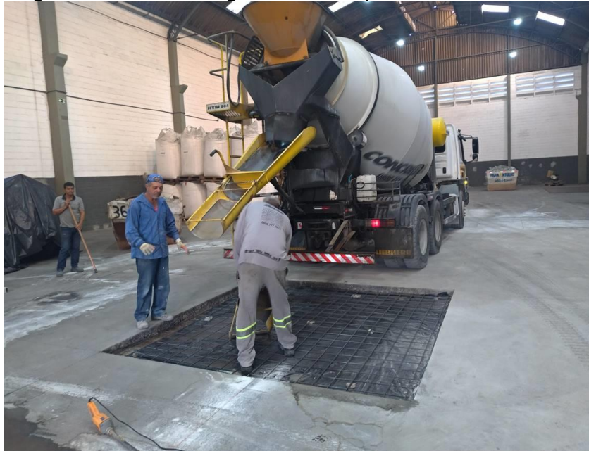
Figura 6.8– Concretagem de outra placa durante reforma
