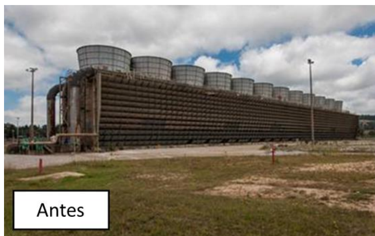
Figura 8 – Situação anterior ao colapso – Torre de resfriamento
