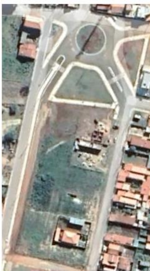
Figura 14. Canteiros e rotatória da Avenida Panema
