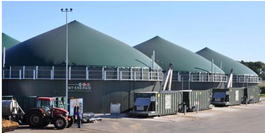
Figura 3.3.: Planta de biogás com três estágios (MT Energie, Zeven, Alemanha)
