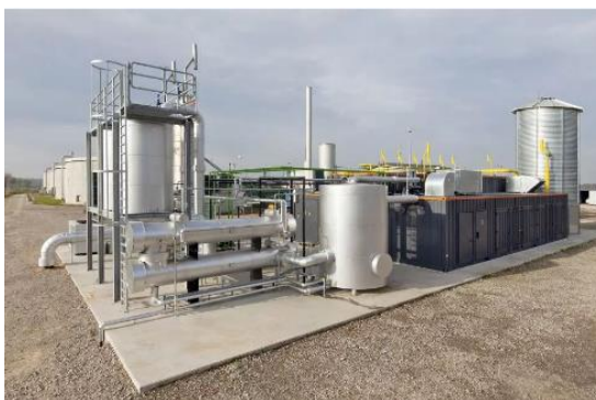
Figura 3.6.: PSA para 5.000 Nm 3 /h – ZORG Biogas
