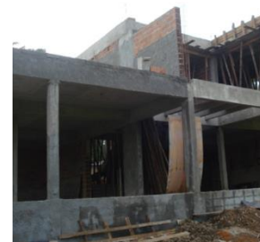
c) Concreto armado/alvenaria de vedação
