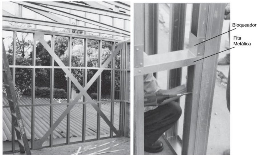
Figura 11 - Contraventamento X, bloqueador
