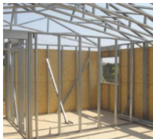
a) Steel Frame
