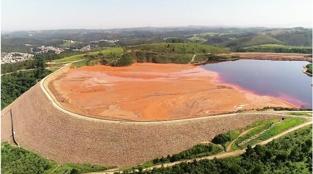
Figura 5 - Resíduo de Bauxita Estocado em Barragem
