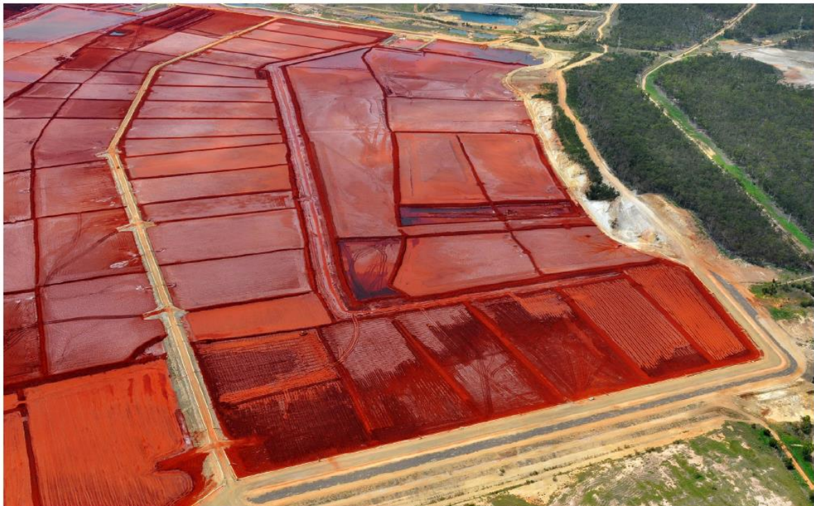
Figura 6 - Resíduo de Bauxita Estocado pelo método de Dry Stacking
