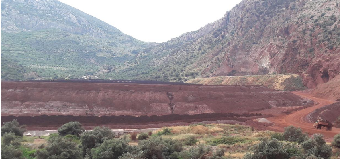
Figura 7 - Resíduo de Bauxita Estocado pelo método de Dry Disposal
