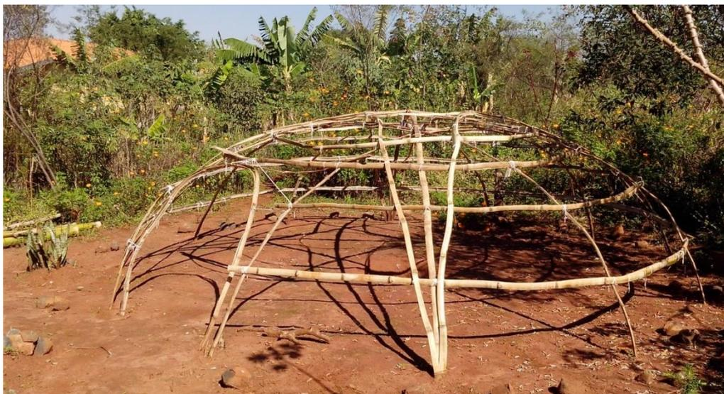
**Figura 31:** Registro da montagem da estrutura da tenda (Fonte: O autor).
