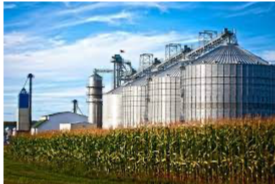
Figura 12 - Silos de Secagem de Milho
