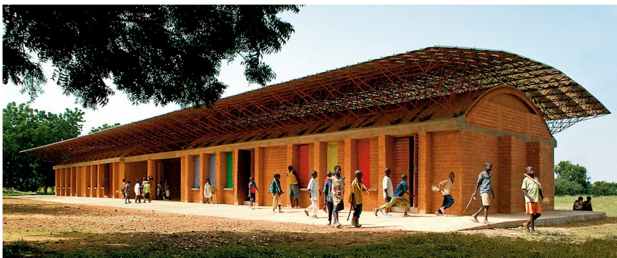
Figura 38 – Ampliação da escola primária de Gando, Burkina Faso, 2008
