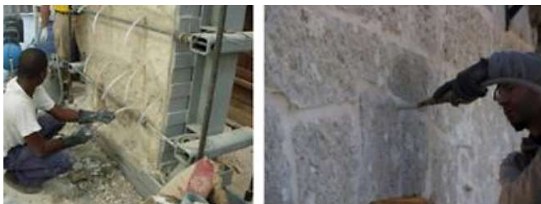
Figura 3.11 – Exemplo de aplicação de técnica de injeção de grouts [43].
