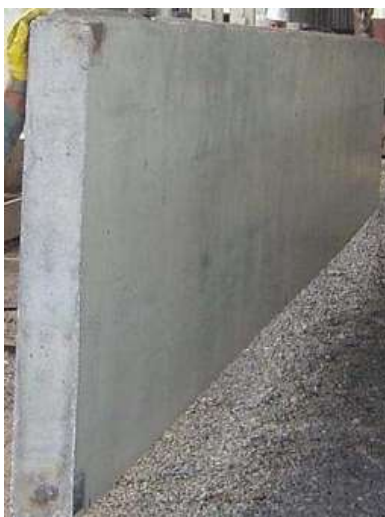
Figura 3.15 – Painel de fechamento constituído por CLEPE [50].
