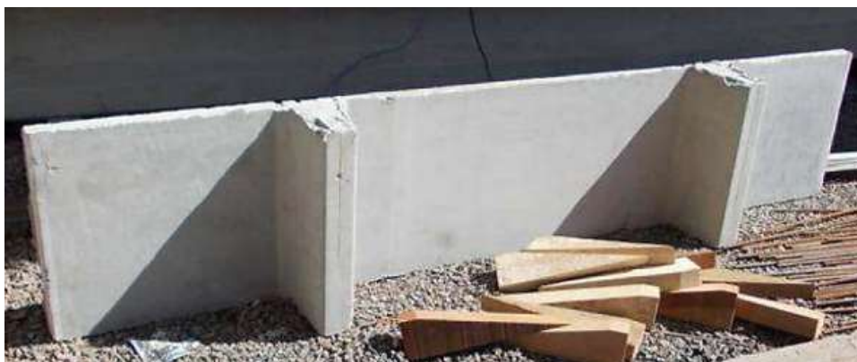
Figura 3.16 – Painel de laje PI (formato duplo T) de CLEPE [50].
