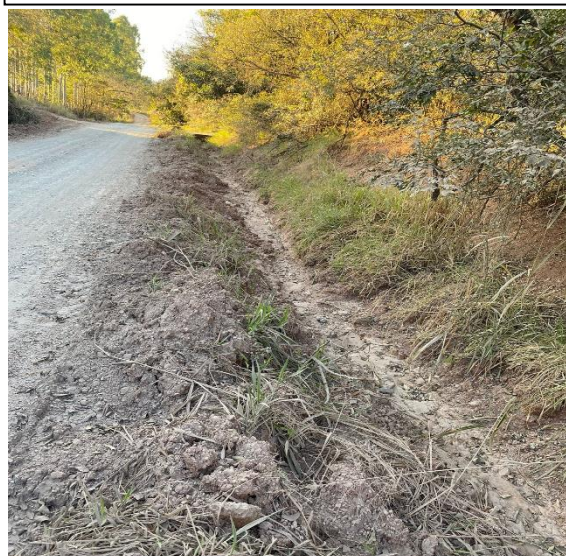
Figura 19 - Realização de valas nas laterais da via
