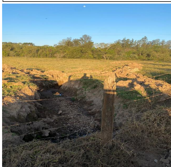
Figura 21 – Obra em execução buscando o manejo de águas pluviais
