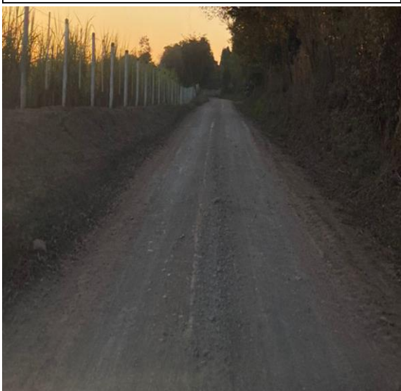
Figura 18 - Manutenção da via tendo em vista os pontos de escoamento
