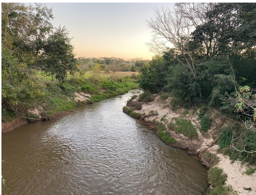
Figura 22 - Margem do rio apresentando assoreamento e inexistência de mata ciliar
