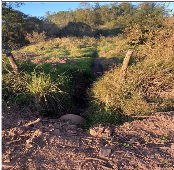
Figura 20 – Obra realizada buscando o manejo das águas pluviais
