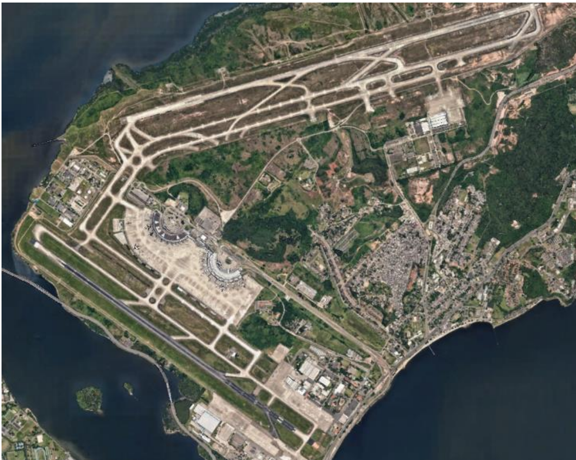
Figura 5 – Pistas do Aeroporto Internacional Antonio Carlos Jobim, no Rio de Janeiro.
