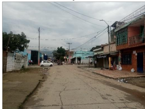
Figura 81 – Via coletora Carrera 12, vista desde Calle 18, direção Oeste
