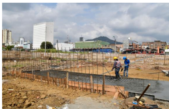
Figura 28 – Primeiros trabalhos de construção das edificações, plano parcial El Calvario
