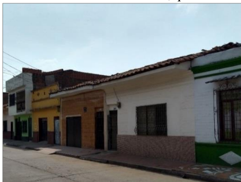
Figura 49 – Prédios em estado de conservação bom, Carrera 11A entre Calles 19 e 20, quadra A0324
