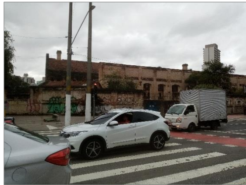
Figura 107 - Bem patrimonial “Complexo do antigo Gasômetro” (No. 4 na figura 105)
