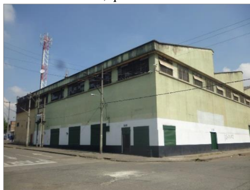
Figura 58 – Uso industrial, Calle 19 entre Carreras 11 e 11B, quadra A0312
