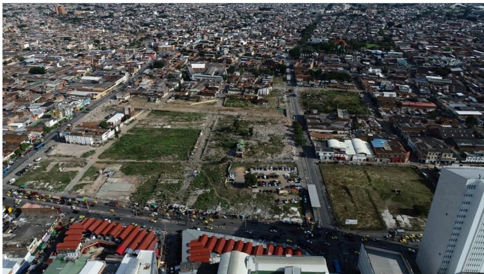
Figura 26 – Visão geral com o processo de demolições do projeto Ciudad Paraíso
