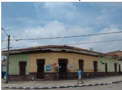
Figura 47 – Prédio em estado de conservação regular, Carrera 12 com Calle 19, quadra A0321
