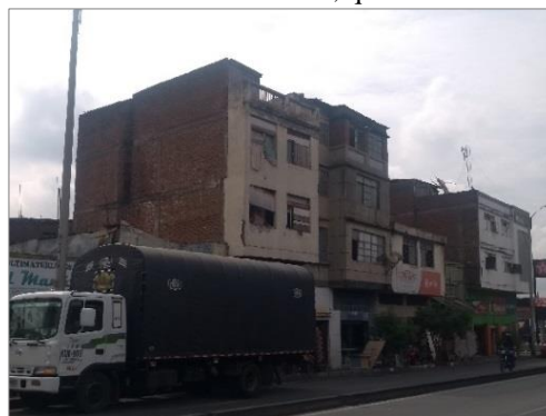
Figura 66 – Prédios com 4 andares sobre Calle 15 entre Carreras 13 e 13A, quadra A0275
