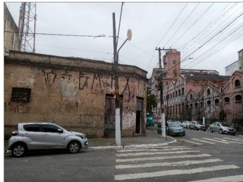
Figura 102 – Prédio de 1 andar, esquina Rua Fernandes Silva com Rua M. Andrade, quadra 98237
