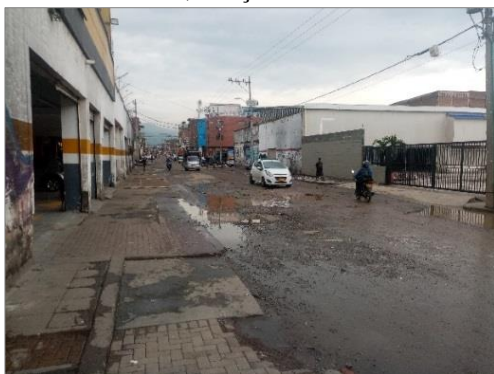
Figura 82 – Via local Calle 19, vista desde Carrera 15, direção Norte
