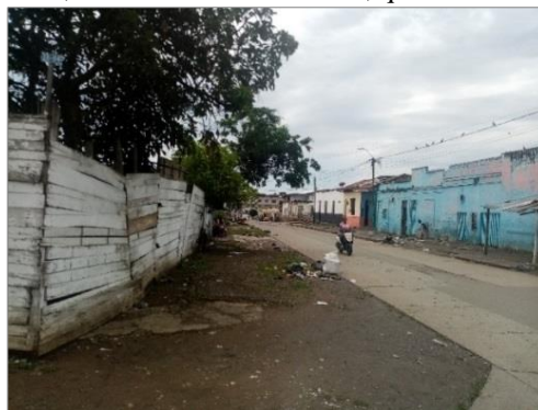
Figura 50 – Prédio em estado de conservação muito ruim, Carrera 12 com Calle 18, quadra A0314
