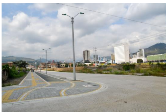
Figura 27 – Adequação do espaço público sobre Carrera 12, Ciudad Paraíso
