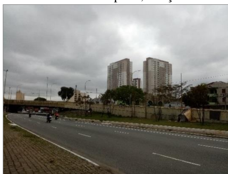
Figura 122 – Via arterial Avenida Mercúrio com Viaduto Diário Popular, direção Leste
