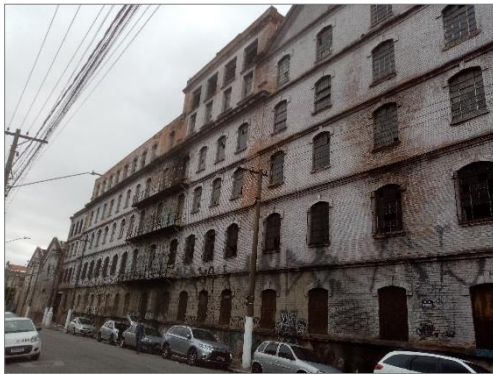
Figura 106 – Bem patrimonial “Antigo Moinho Matarazzo” (No. 2 na figura 105)
