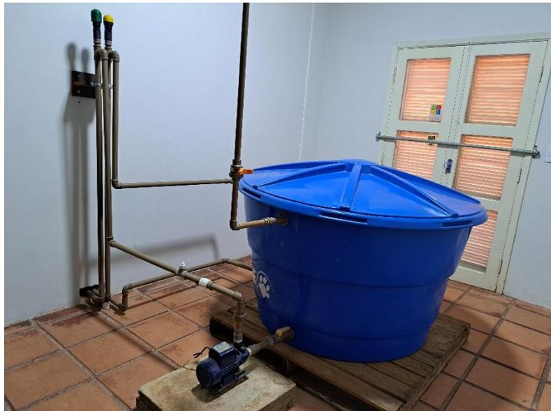
Figura 1 - Reservatório de água, tubulação de recalque e retorno
